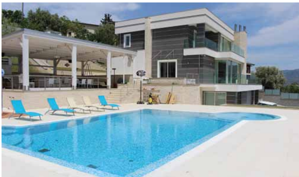
La piscina esterna: riscaldamento acqua, idromassaggio, illuminazione, giochi d'acqua, programmazione filtrazioni, ecc., sono gestibili tramite dei semplici click.
